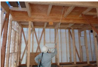
ノズル部分が伸縮できる噴霧器を使うと効率よく作業できます。
